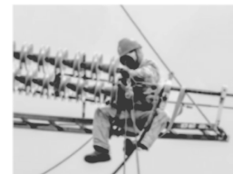
工人穿戴工作服进行超高压带电作用
